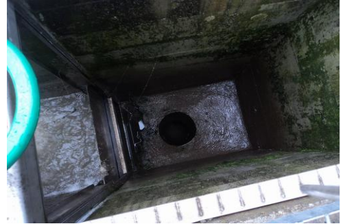
Foto 6. Aspecto do aliviadero á saída do desarenado (16/10/13).
