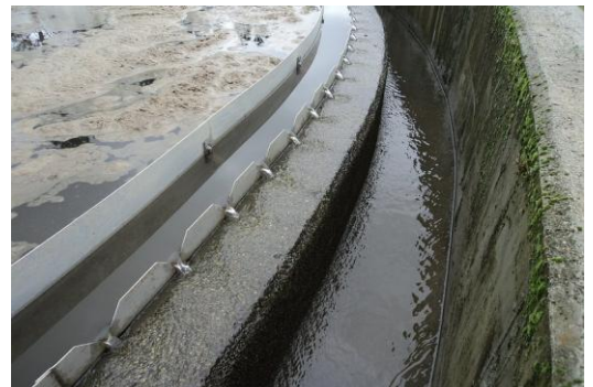
Foto 2. Aspecto do V30 o día 16/10/13. Obsérvase unha boa decantación do fango e un sobrenadante claro.
