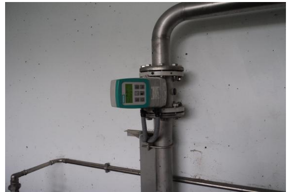
Foto 4. Caudalímetro de fango espesado a filtro banda (16/10/13). Non envía os datos correctamente ó RITES.
