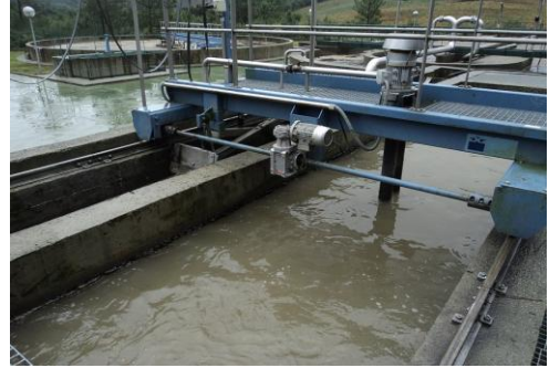
Foto 4. Zona de desarenado-desengraxado (16/10/13).
